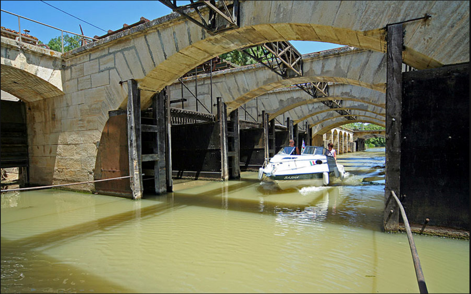
Zapornice Libron pri Viasu
